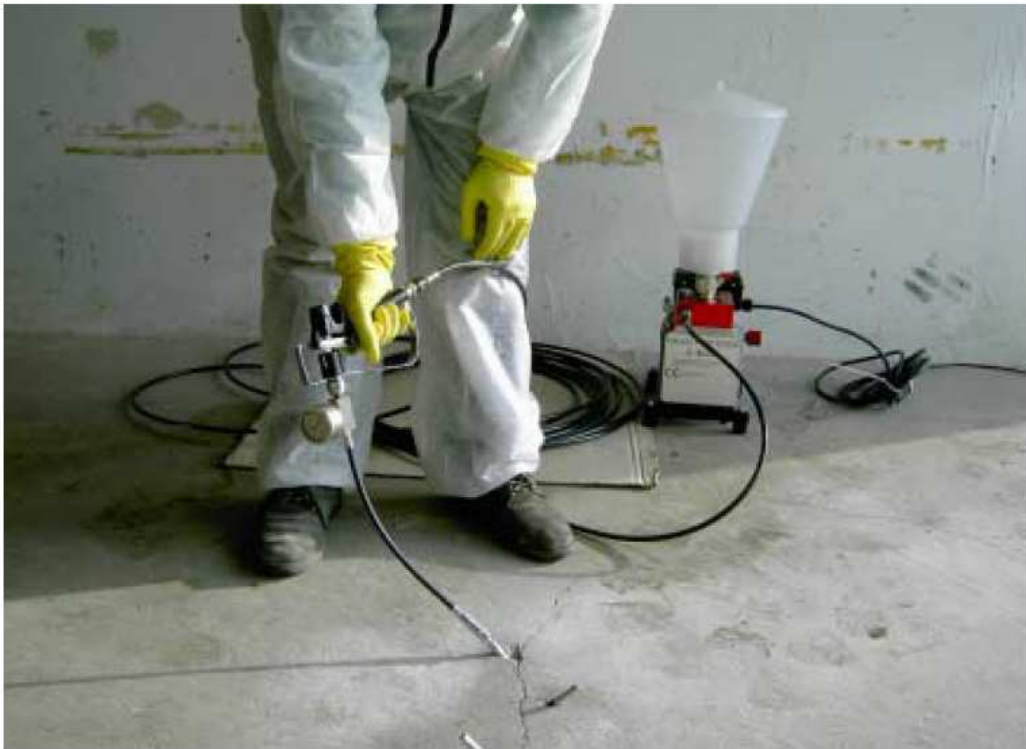
Tlaková injektáž podlahy
